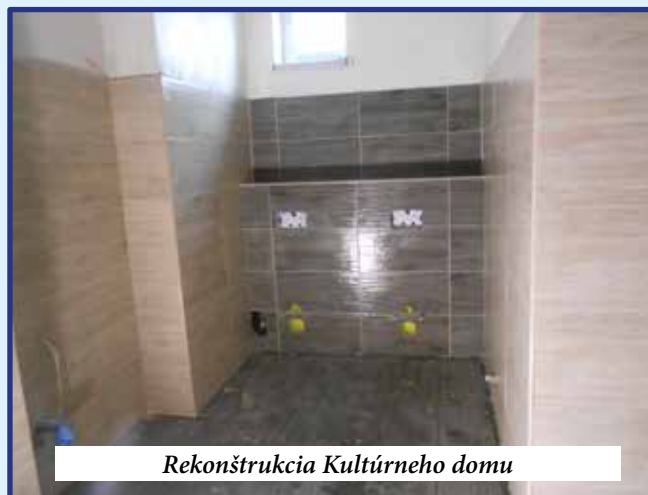
Rekonštrukcia Kultúrneho domu
